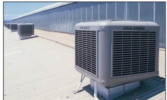
Debido a su poco peso, no es necesaria una grúa para su montaje, ni soporte para su instalación, bastando con su propio conducto.
